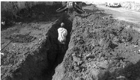
"SE REALIZO EXCAVACION A CAJON PARA ALOJAR LA RED DE DRENAJE SANITARIY LINEA DE AGUA POTABLE"
