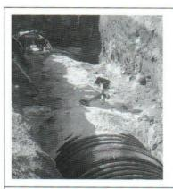
" INSTALACIÓN DE TUBERÍA PEAD N-12 SERIE 65 DE 42" REALIZANDO ACOSTILLADO Y RELLENO COMPACTADO CON MATERIAL DE BANCO"
