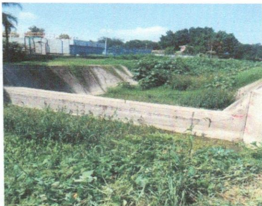
"ESTADO INICIAL DE CANAL"
