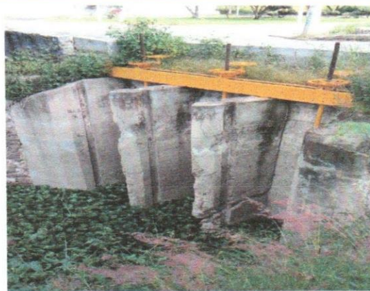
"ESTADO INICIAL DE COMPUERTAS A REHABILITAR"
