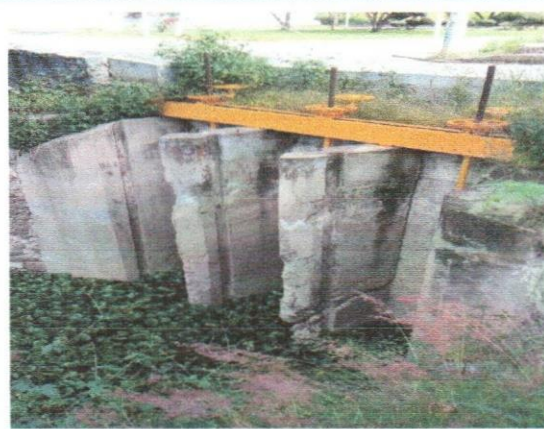
“ESTADO INICIAL DE COMPUERTAS A REHABILITAR”
