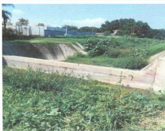
“ESTADO INICIAL DE CANAL”
