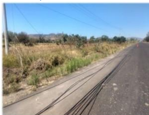
Tendido de fibra óptica
