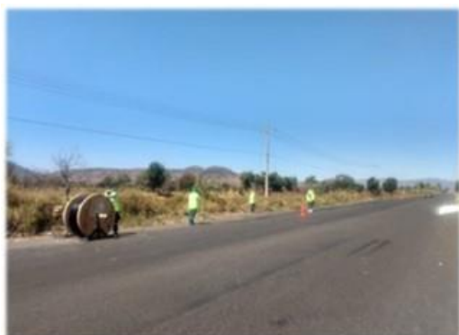
Tendido de fibra óptica
