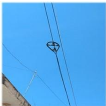
Instalación y embobinado de cable sobre acero
