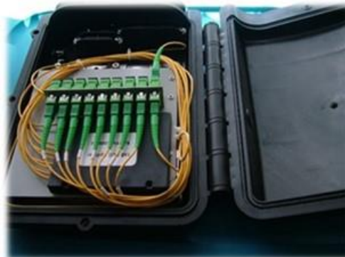
Acomodo de Splitter's y cables en cierres de empalme
