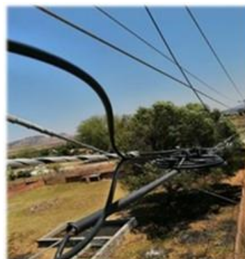
Instalación y embobinado de cable sobre acero
